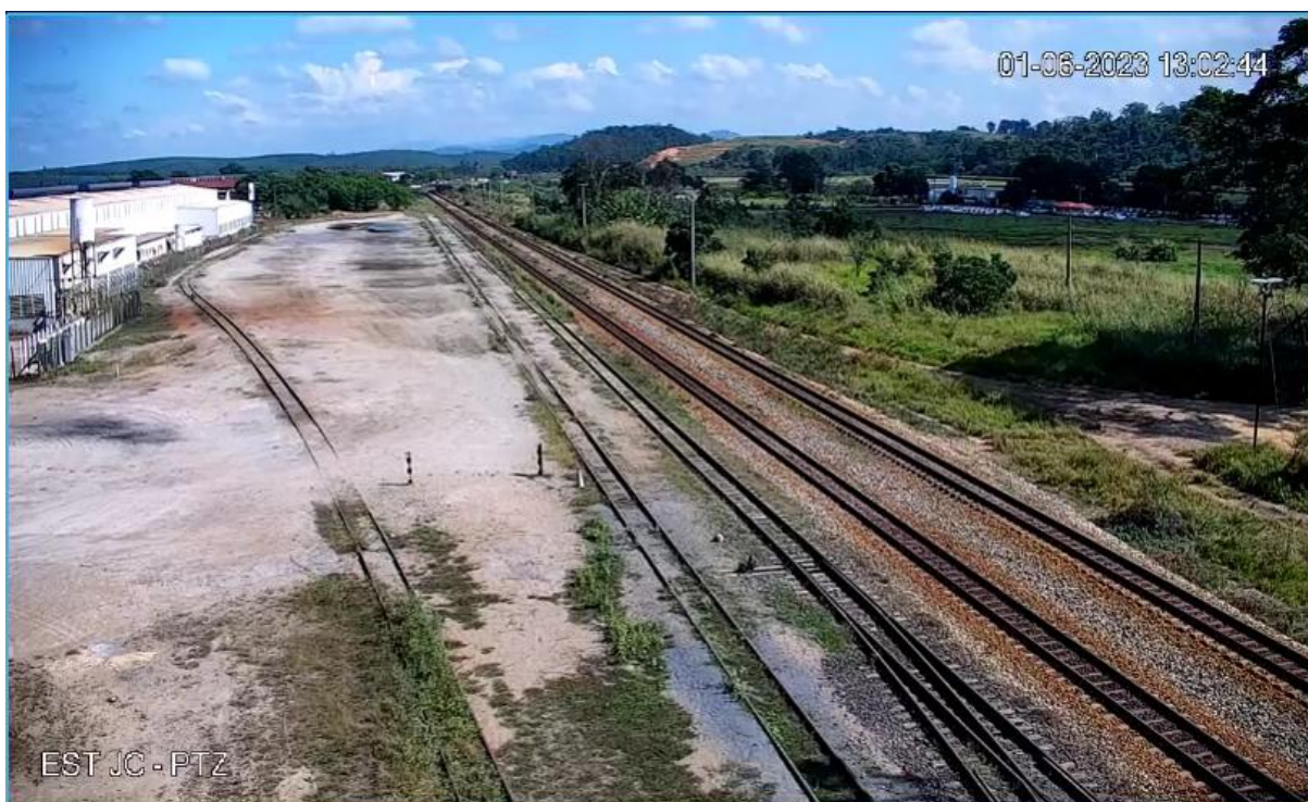
Figura 3 – Visão Geral do Pátio de VJC com foco na área de carregamento
