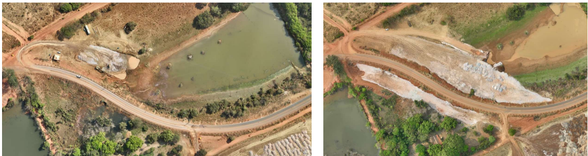
Figura 5: Avanço da execução do tratamento de fundação de aterro – imagens com 30 dias de diferença.
