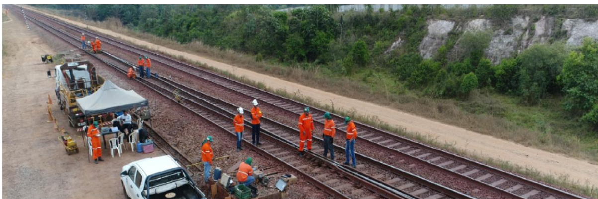
Figura 1 – Equipe de manutenção sobre a via férrea EFC
