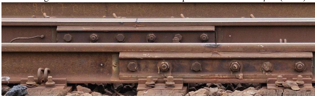
Figura 3 – Par de JIC 1 aos 1124 dias após a última substituição. (AGO)
