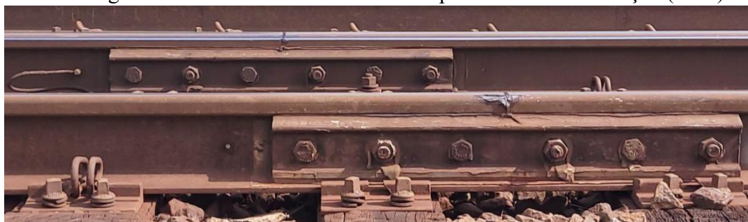
Figura 4 – Par de JIC 1 aos 1229 dias após a última substituição.(DEZ)
